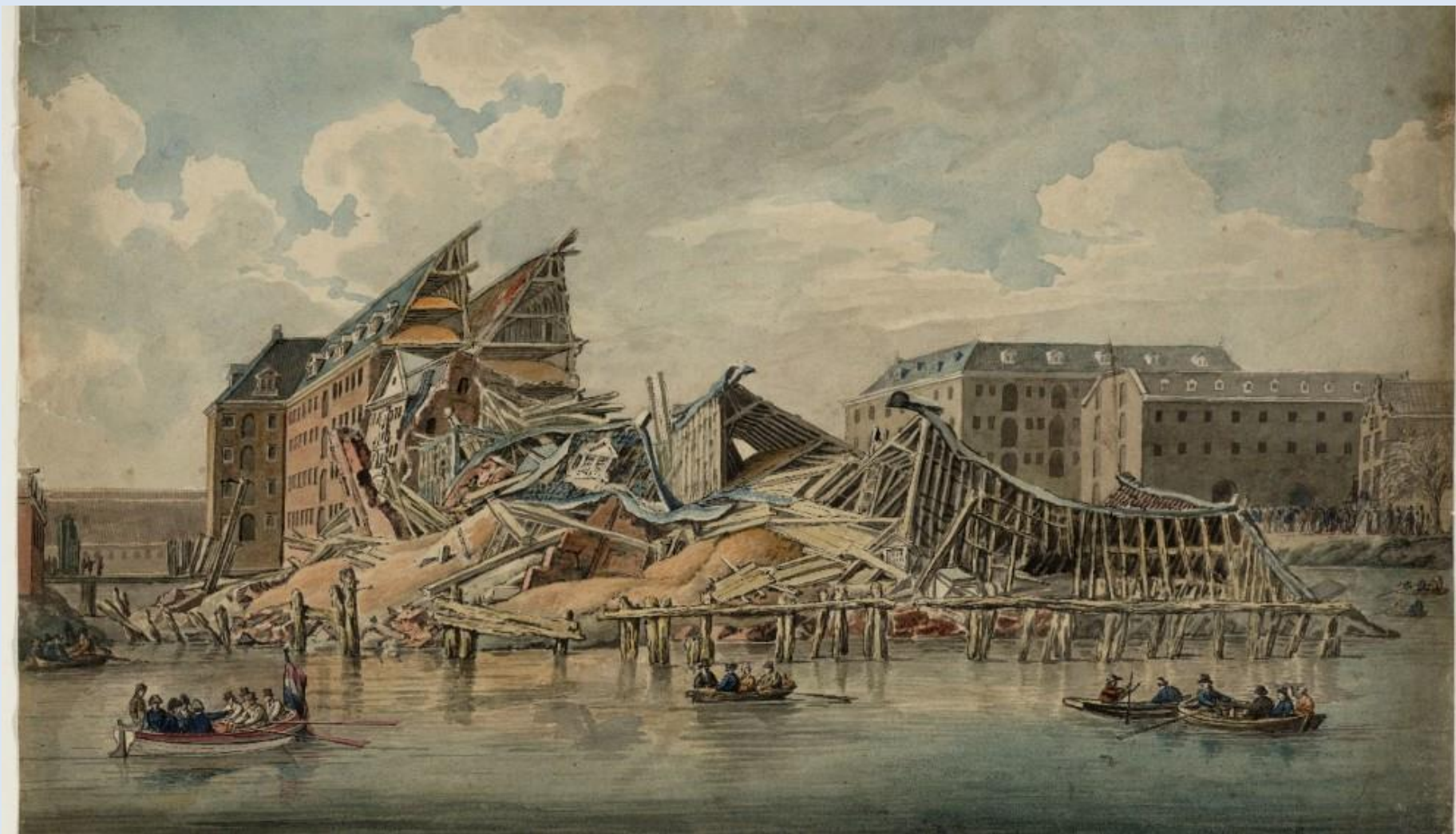
Ineenstorting Zeemagazijn VOC op Oostenburg
